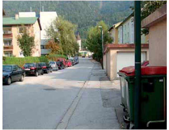
Zu sanierender Gehsteig in der Baumgartnerstraße
