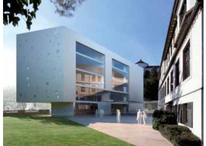
Der Zubau aus Richtung Schillerstraße
