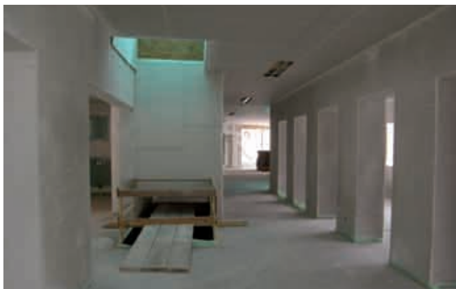
Bauarbeiten im Inneren
