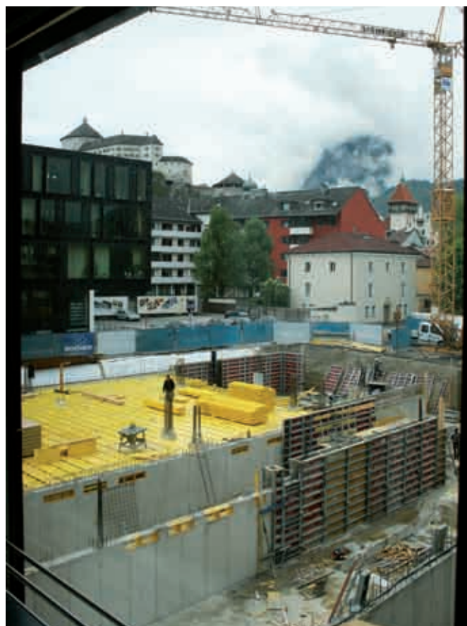
Stand der Bauarbeiten Anfang Mai
